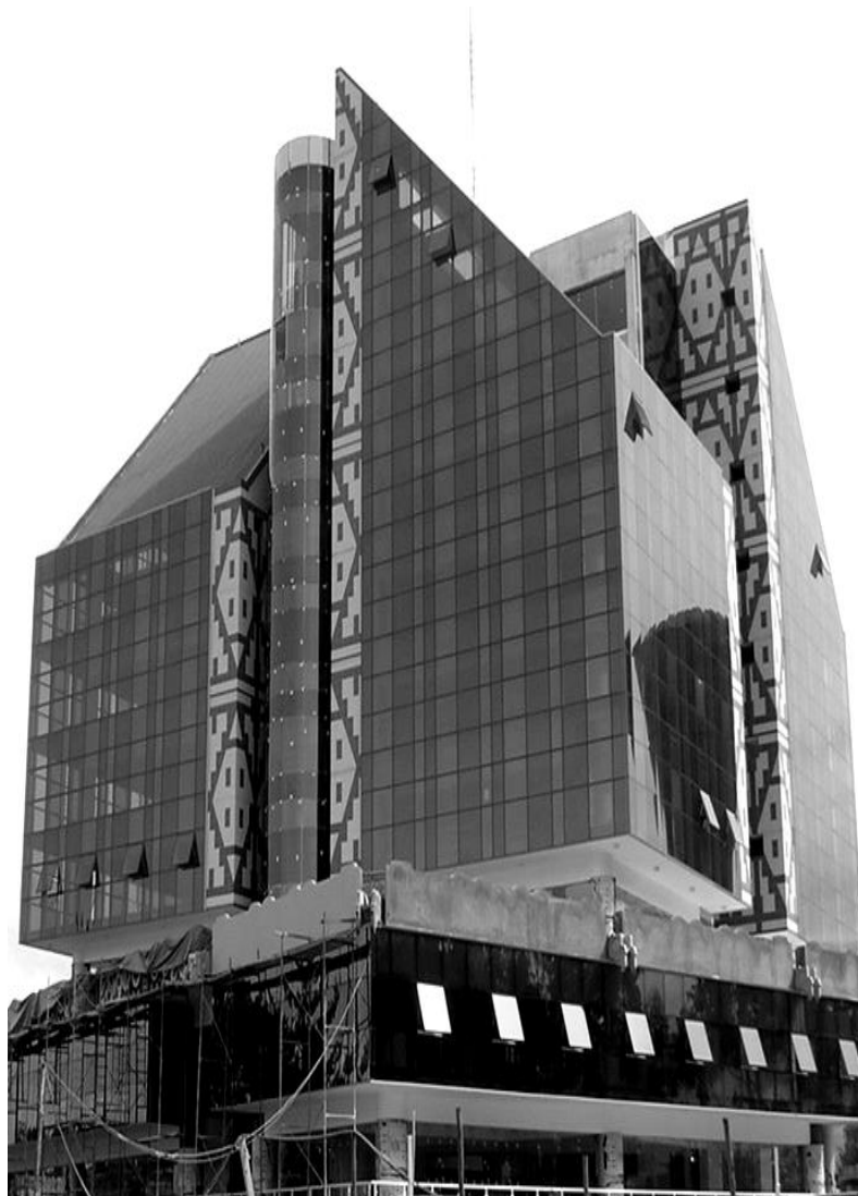
Moderno Edificio de Administración y Gobierno de la UNCP en etapa de construcción. Archivo personal.
